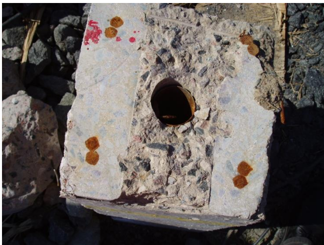
Figur 13 Kapad provpåle med ingjutet stålrör.
